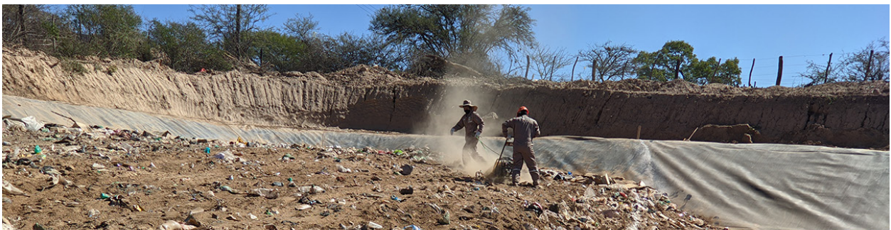
Proceso de Cierre y Rehabilitación de botaderos del Chaco. Basura Cero en Bolivia.
